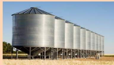
Наличие 2 элеваторов с железнодорожным тупиком
